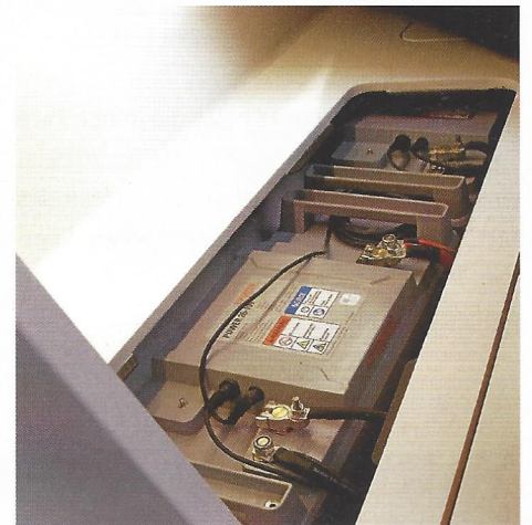
Diese Lithium-Ionen-Akkus sind nur für den Motor zuständig.
